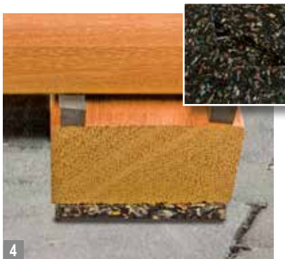
4 Gummi reguliert: Höhenausgleich-Pads für die Unterkonstruktion.
