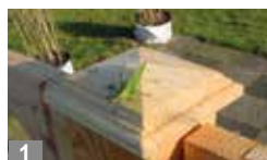
1 Abdeckplatte Lärche, profiliert
