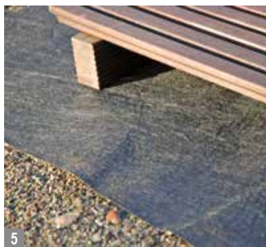
5 Wasserdurchlässiges Abdeckvlies gegen Durchwurzelung und Pfützenbildung.
